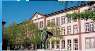
ifab-Zentrale: Altes Maschinenbaugebäude
